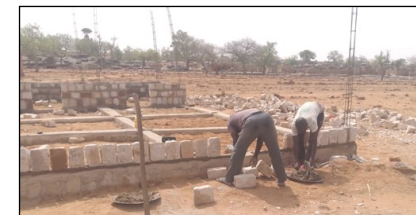
Le fondamenta della carpenteria in Mali
